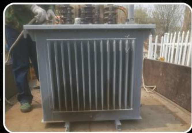
变压器散热器渗油
